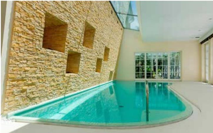
Der Boden der exklusiven Schwimmbhalle wurde mit einem hellen, rutschhemmenden Technostein belegt. Die schräge Wand wurde mit einer Bruchsteinmauer versehen. Das Mosaik im Pool (mit Überlaufrinne) besteht aus türkischem Muranoglas in der Steingröße 1,5 x 1,5 cm. Einen besonderen Reiz bietet das Streiflicht auf der Mauer durch die Dachflächenfenster.
